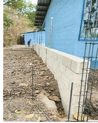
Foto 2: COLOCACIÓN DE BLOCK PARA MEJORAMIENTO DE CERRAMIENTO DE MURO PERIMETRAL.
