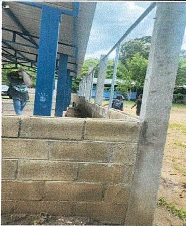
Foto 3: MEJORAMIENTO DE COLUMNAS E INSTALACIÓN DE TUBOS GALVANIZADOS.
