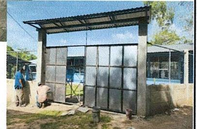
Foto 4: INSTALACIÓN DE MALLA E INSTALACIÓN DE PORTÓN DE METAL Y TECHO PROTECTOR PARA MEJORAMIENTO DE CERRAMIENTO DE MURO PERIMETRAL.
